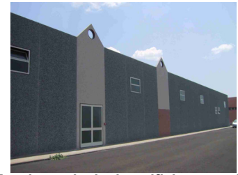
Facciata principale opificio con celle
